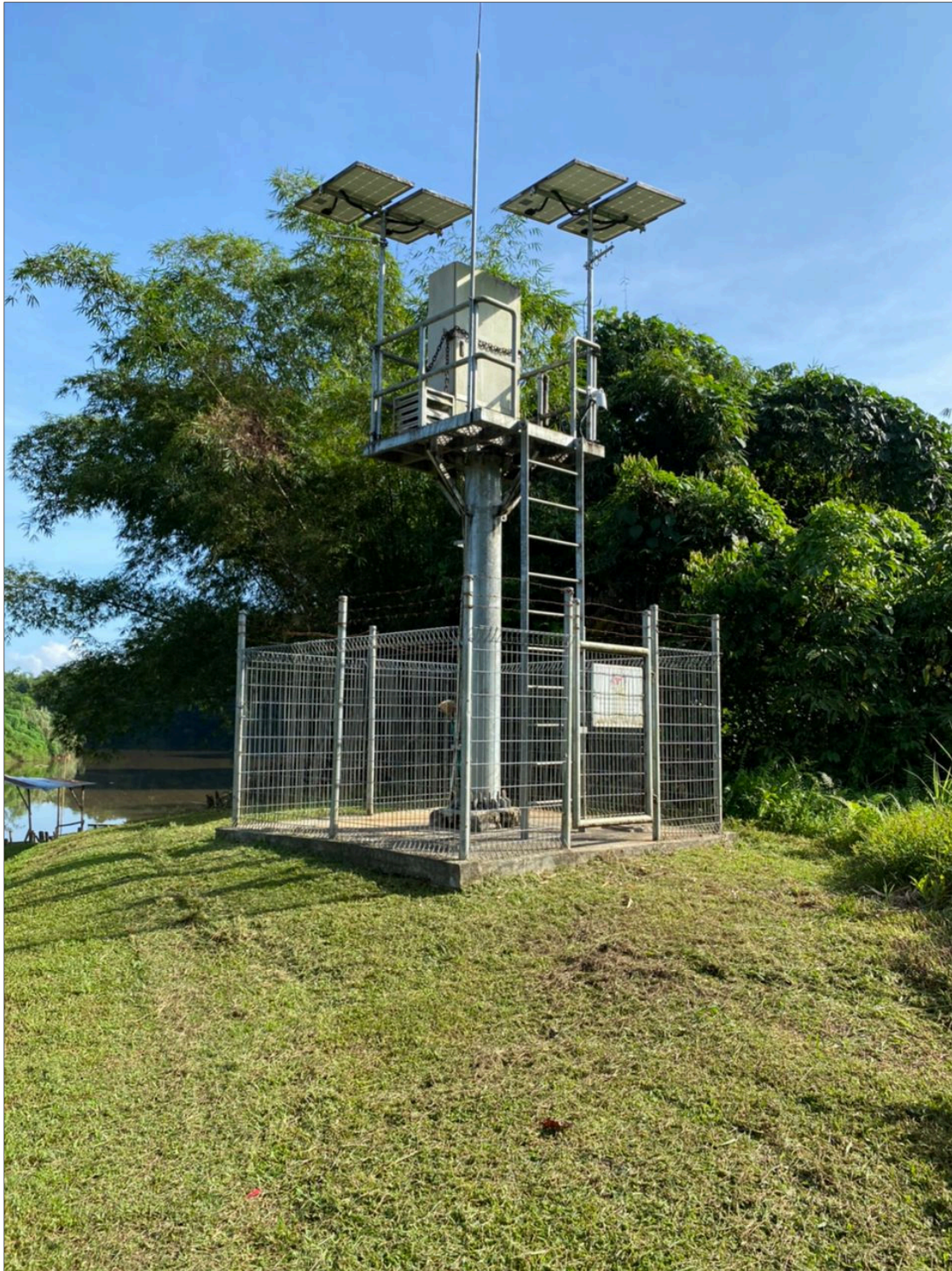
Foto 4.4: Stesen pengawasan kualiti air sungai automatik (CRWQM) yang terletak di Sungai Sarawak Kiri
