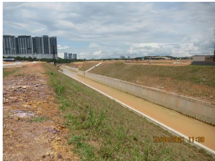
Gambar 3.2: Tebing yang telah dijalankan turfing dan concrete drain yang menghalang hakisan
