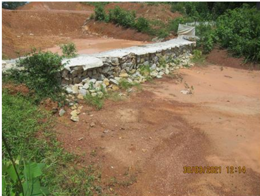
Gambar 3.4: Pembinaan rock gabion yang betul menghalang kelodakan memasuki aliran air awam
