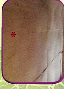
Siling plywood yang telah dibaik pulih
