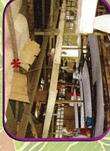
Siling plywood yang rosak
