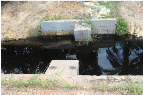
Gambar 1: Sekatan saluran blok konkrit, Muar, Johor
