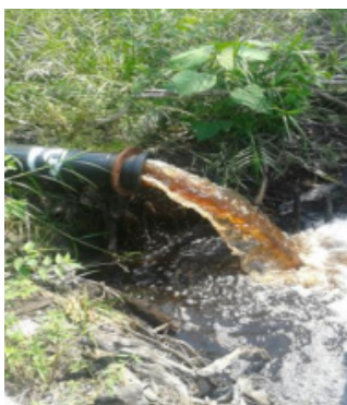
Gambar 37: Penyaluran air dari saluran paip air ke dalam kawasan tanah gambut
