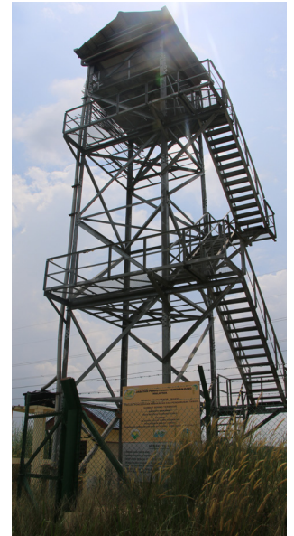
Gambar 29: Menara tinjau, Penur, Pahang
