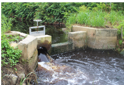
Gambar 4: Sekatan saluran konkrit "spin wheel", Klias, Sabah
