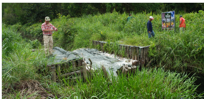
Gambar 8: Sekatan saluran menggunakan kayu keras dan "earth-filled geobag", Klias, Sabah
