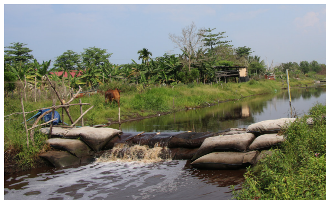
Gambar 7: Sekatan saluran "earth-filled geobag", Penur, Pahang
