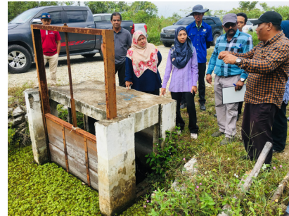
Gambar 3: Sekatan saluran konkrit "spin wheel", Hutan Simpan Kuala Langat Utara, Kuala Langat, Selangor
