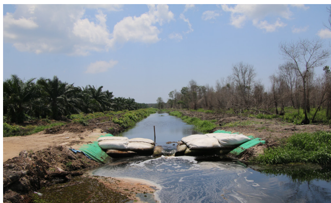
Gambar 6: Sekatan saluran "earth-filled geobag", Setiu, Terengganu
