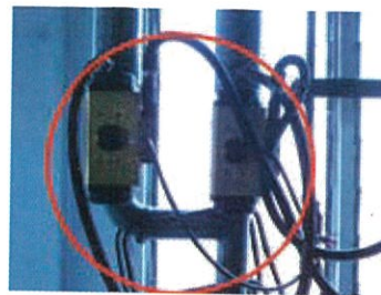
Pemasangan Injap Kawalan Pneumatik
