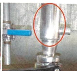
Pemasangan paip berdiameter 2.0 inci
