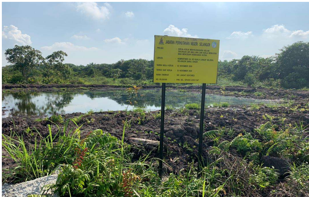
Foto 4.16: Kolam takungan yang dibina di kawasan fire prone di Negeri Selangor
