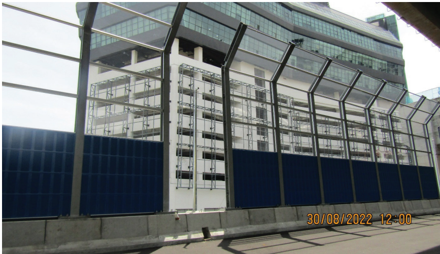
Gambar 2.15: Noise barrier telah dipasang di sebahagian jajaran pakej CA-3 projek SUKE.
