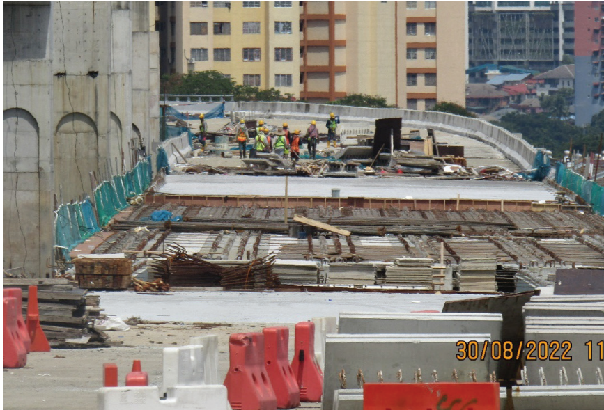
Gambar 2.14: Kerja-kerja pemasangan launching beam dan parapet sedang giat dijalankan di jajaran pakej CA-3 projek SUKE.
