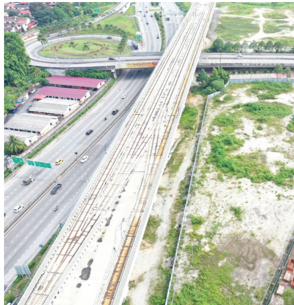
Gambar 2.1 : Pemeriksaan menggunakan Dron untuk semakan tapak bagi permohonan Penilaian Input Pembangunan
