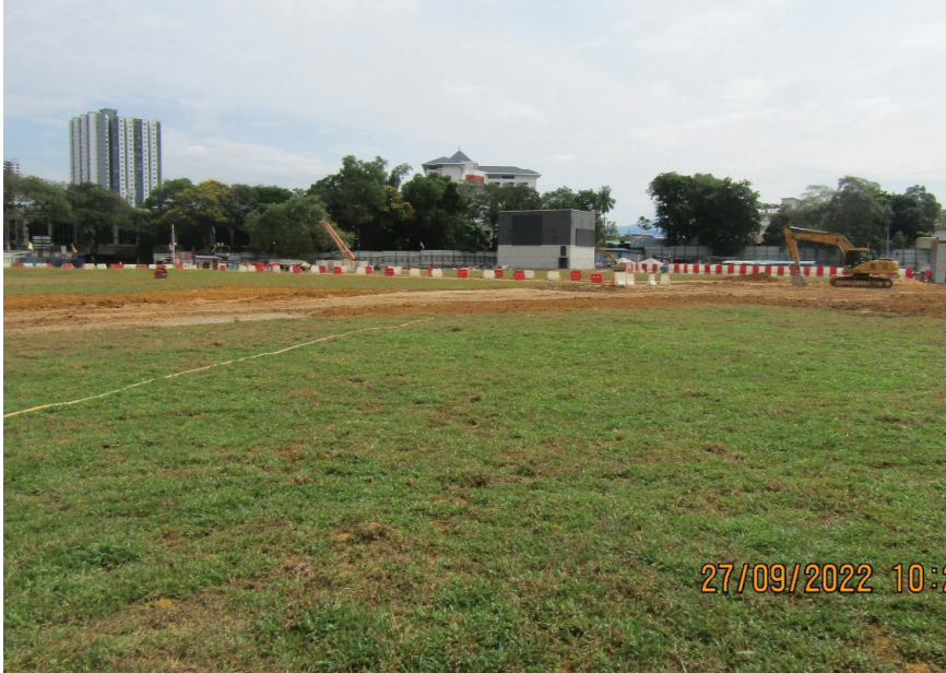
Gambar 2.12: Pemeriksaan turfing di tapak Stesen MRT Titiwangsa. Kawasan ini dahulunya dibina kolam mendapan dan telah ditutup sepenuhnya.
