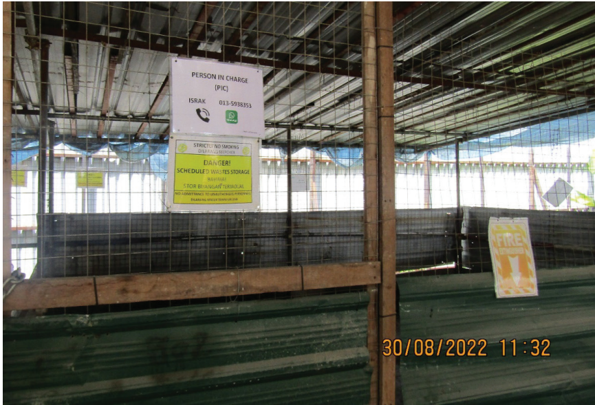
Gambar 2.16: Pemeriksaan tapak penstoran Buangan Terjadual (BT).
