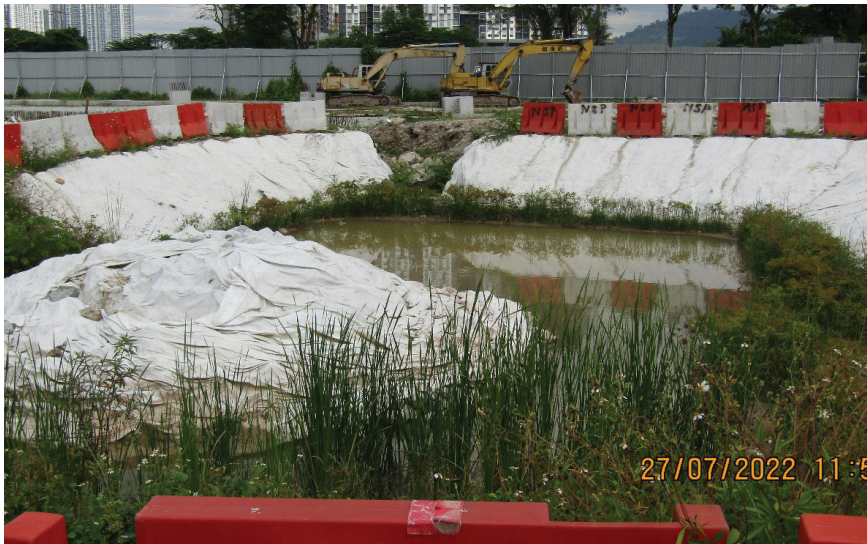
Gambar 2.24: Pemeriksaan kolam takungan yang terdapat di tapak projek stesen pemindahan sisa pepejal
