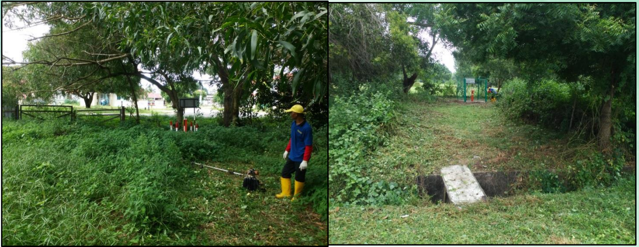
Gambar 2.10 Kelantan: Kerja-kerja penyelenggaraan telaga air bawah tanah.
