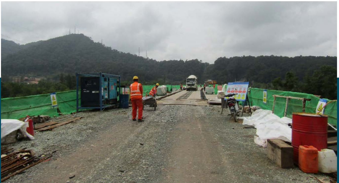
Gambar 2: Kerja – kerja pembinaan jambatan oleh CCC(ECRL) Sdn Bhd
