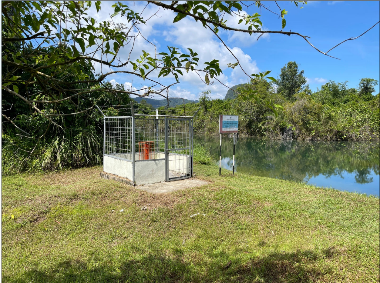
Foto 4.9: Stesen pengawasan kualiti air tanah yang terletak di Loji Rawatan Air Bau
