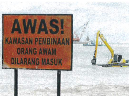
KERJA menambak Pantai Telok Gong giat dijalankan kontraktor dilantik JPS. Foto Iqmal Haqim Rosman
