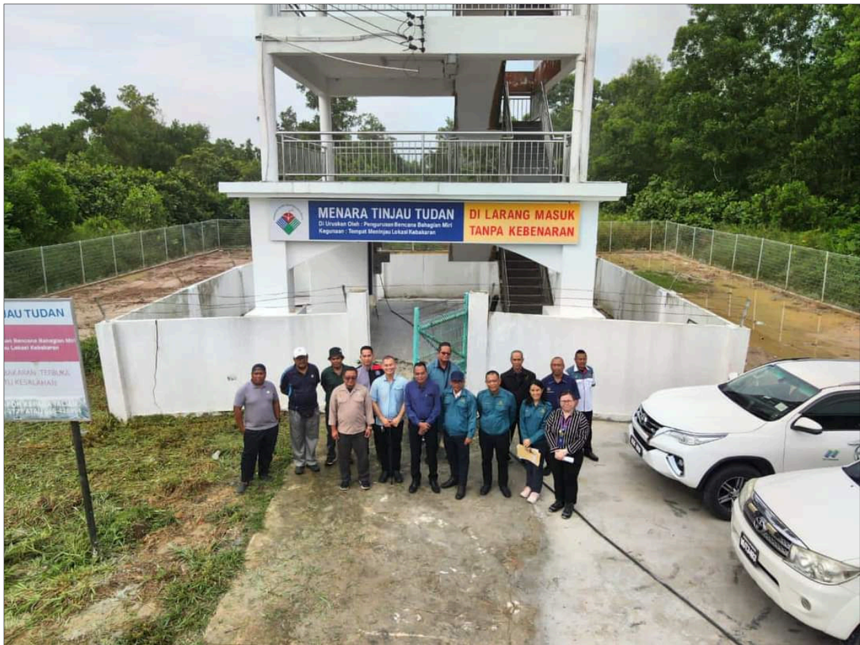
Foto 3.17: Program pengauditan infrastruktur tanah gambut di Menara Tinjau Tudan, Miri pada 26 September 2023
