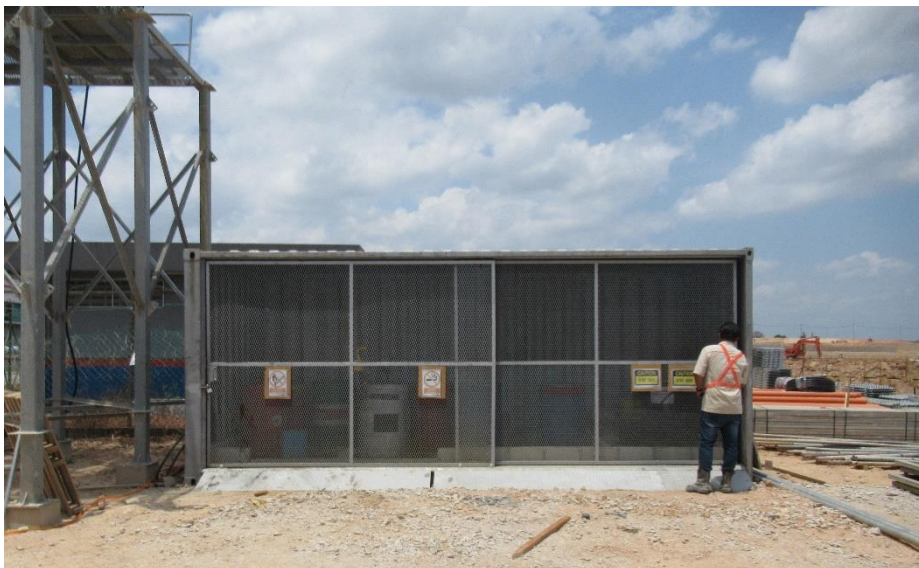
Rajah 2.15: Pengurusan buangan terjadual yang baik dengan membina stor yang berbumbung dan berpagar
