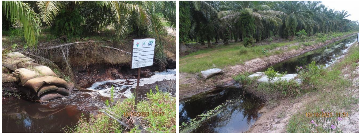
Rajah 8.24: Check Dam di kawasan tanah gambut
