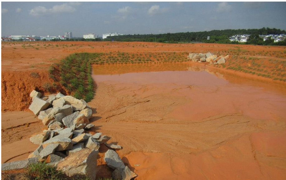
Rajah 2.17: Kegagalan melengkapkan unit BMPs mengikut spesifikasi yang ditetapkan.
