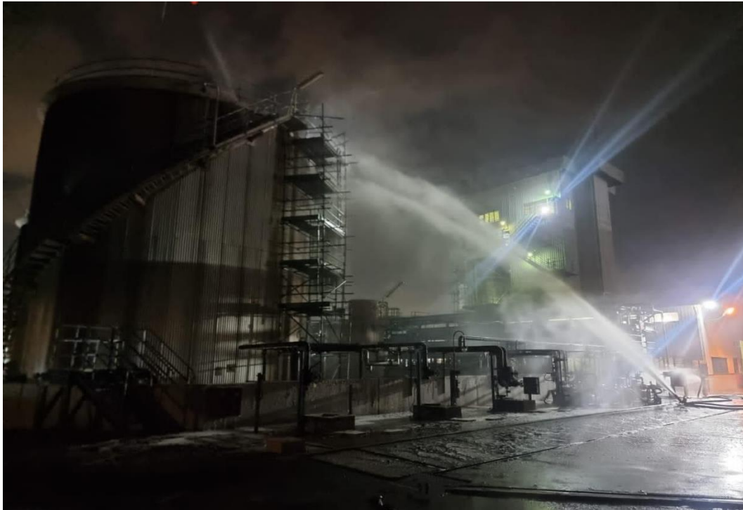
Rajah 8.20: Operasi penyejukan tanki (cooling tank) Styrene Monomer oleh Pasukan Bomba dan Penyelamat
