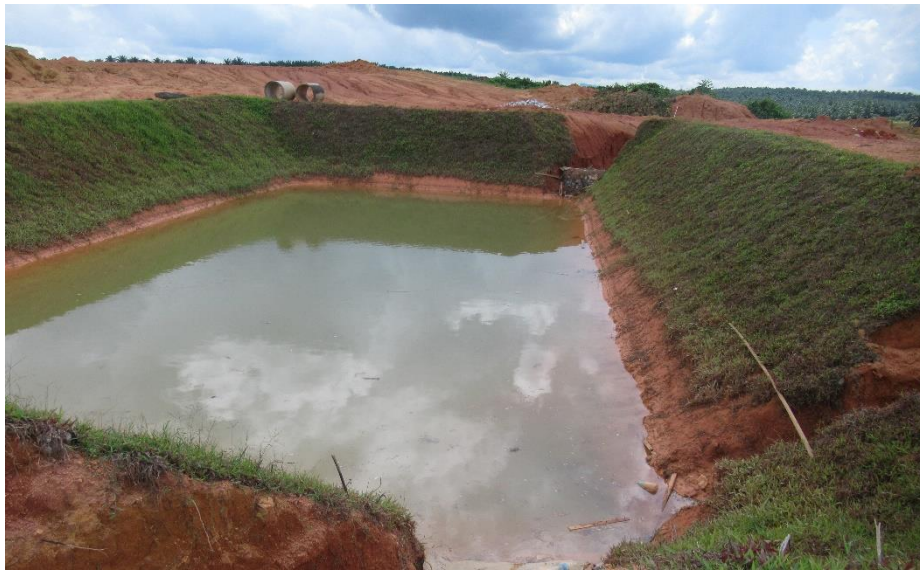
Rajah 2.11: Kolam perangkap mendap yang dalam dan berfungsi dengan baik
