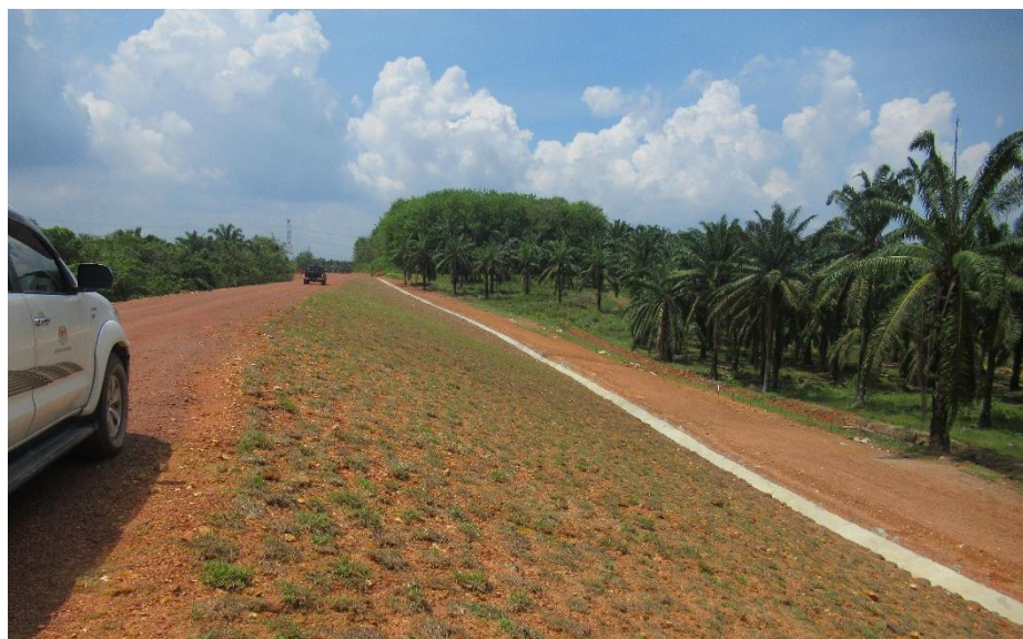
Rajah 2.13: Pembinaan concrete drain sepanjang parameter projek mengelakkan limpahan air berkelodak ke badan air awam
