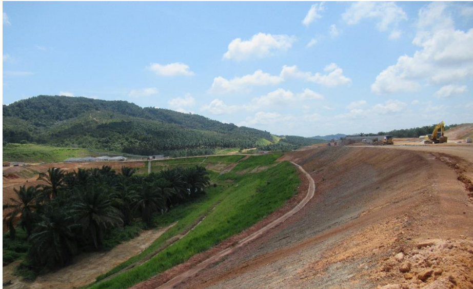
Rajah 2.12: Terracing dan penanaman rumput tutup bumi yang baik untuk menghalang hakisan teruk
