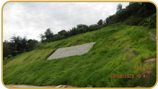
Gambarfoto 2.11 : Turfing Cerun Yang Terdapat Di Projek Universiti Pertahanan Negara Malaysia (UPNM)
