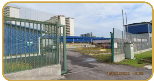
Gambarfoto 2.8 : Pemeriksaan Loji KLR 360 Yang Menggunakan Sistem Sequencing Batch Reactors (SBR) Telah Siap Dan Beroperasi
