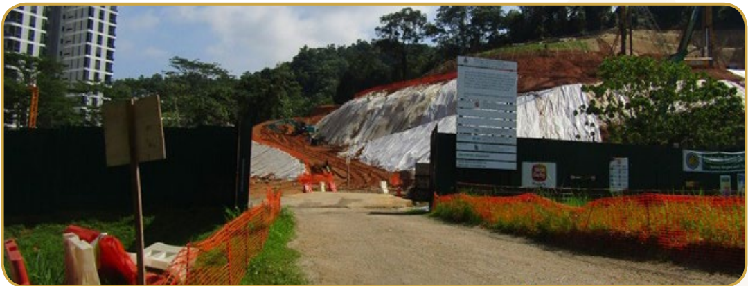
Gambarfoto 2.12 : Pembangunan Cerun Yang Terdapat Di Projek KL East
