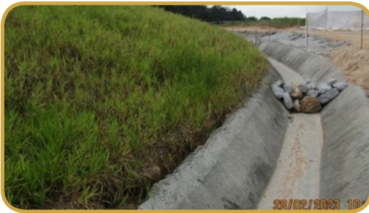
Gambarfoto 2.10 : Pemeriksaan Earth Drain Di Projek Universiti Pertahanan Negara Malaysia (UPNM)
