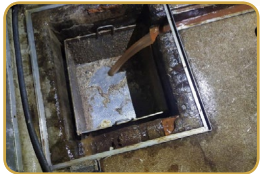
Gambarfoto 3.6 : Lubang Longkang (Sump Pit) Yang Digunakan Untuk Mengalirkan Efluen Perindustrian Ke Alur Air
