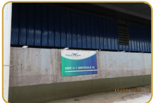
Gambarfoto 2.9 : Pemeriksaan Loji KLR 360 Yang Menggunakan Sistem Sequencing Batch Reactors (SBR) Telah Siap Dan Beroperasi
