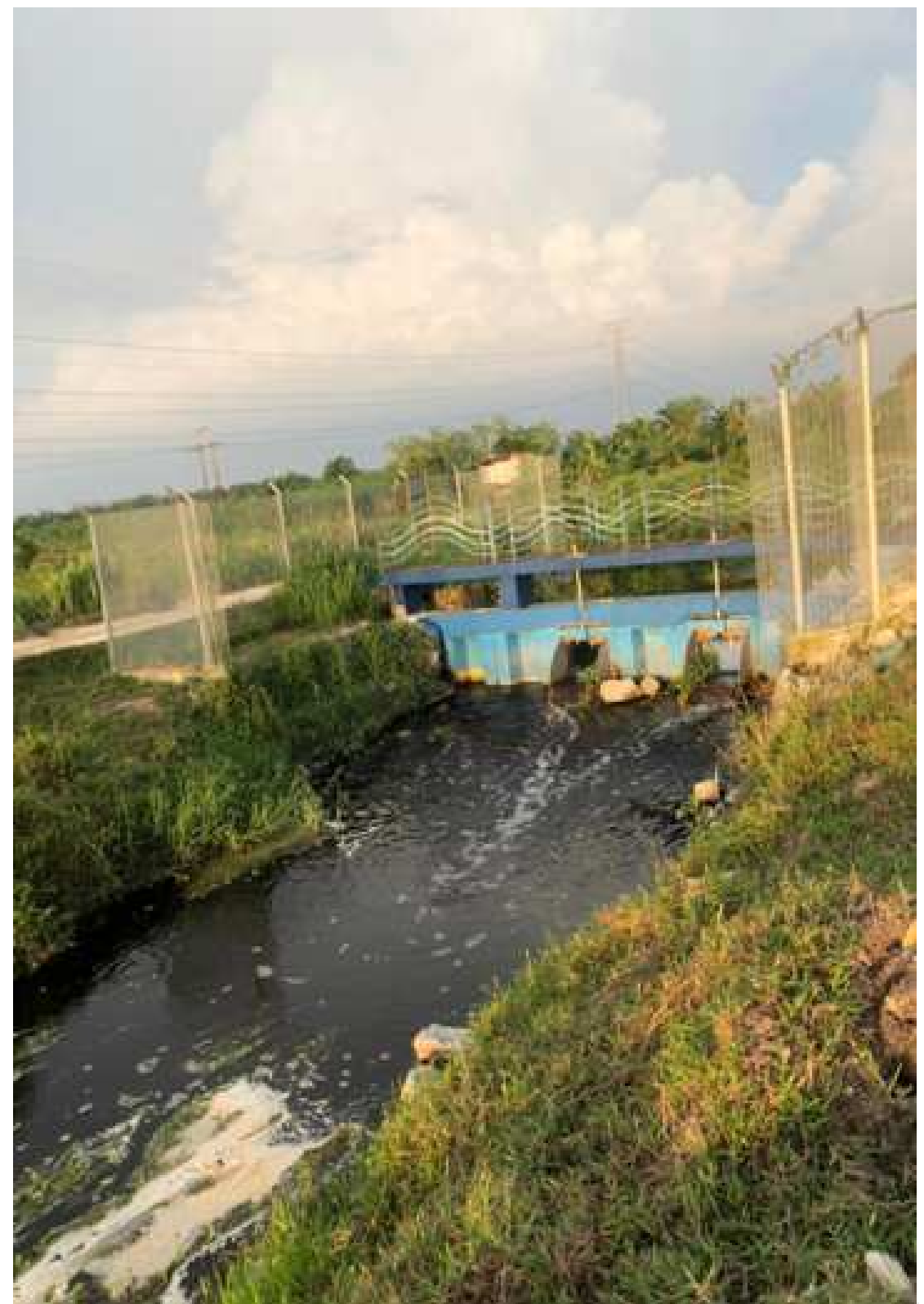
Foto 4.14: Check dam jenis geobag dan spin wheel yang dibina di kawasan fire prone di Negeri Selangor
