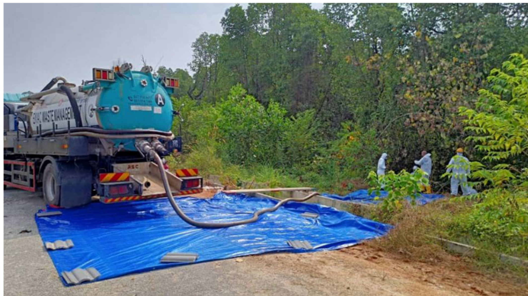
Kerja membersihkan lokasi dijadikan tapak pelupusan buangan terjadual. - FB JAS
