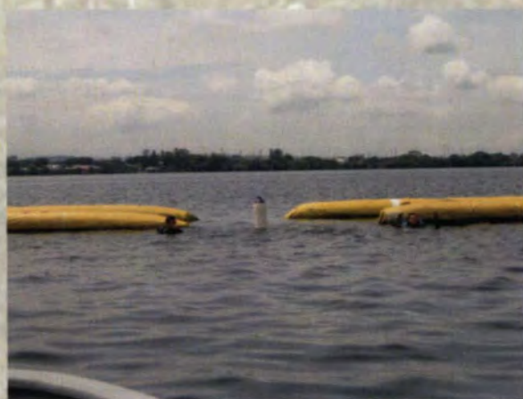
Plat 3.2 JAS Johor : Aktiviti Pemeriksaan Tirai Kelodak Oleh Pasukan Penyelam JAS Johor
