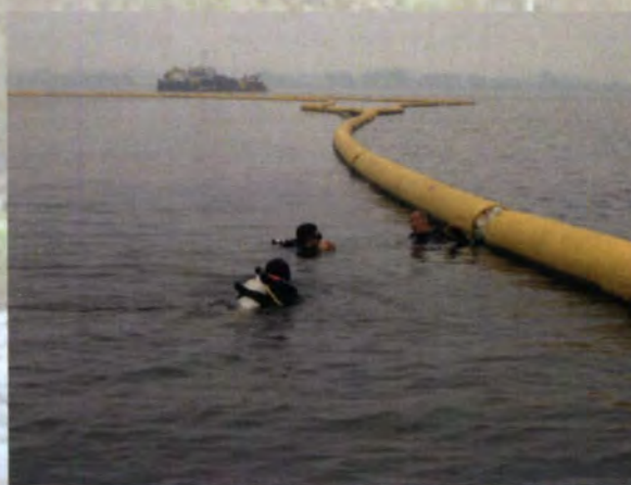
Plat 3.3 Johor : Tirai Kelodak Yang Tidak Bersambung Menjejaskan Fungsi Sebenar Dalam Menghalang Kelodakan Terlepas Keluar.
