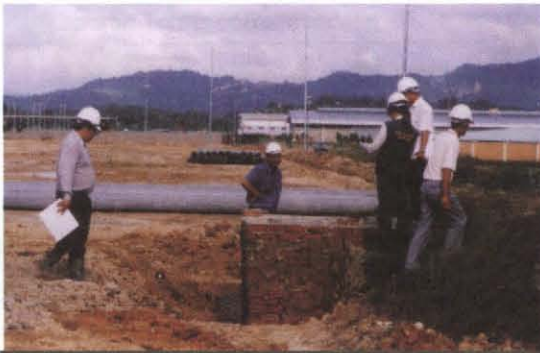
Gambar 3.3 : Sabah : Pemeriksaan pematuhan langkah mitigasi yang dicadangkan pada tapak kawasan premis EIA semasa kerja-kerja tanah dijalankan.
