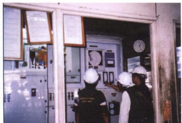
Gambar 4.4 : Pemeriksaan Alat "Smoke Density Recorder" Di Premis PYDT.
