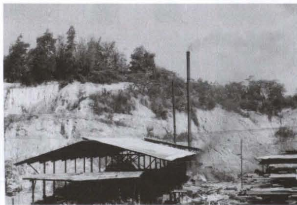
Gambar 4.9 : Sabah : Pemerhatian asap hitam dari se buah premis yang m elepaskan asap dengan alat kawalan yang tidak berfungsi sepenuhnya. Kelihatan asap hitam tidak keluar se penuh melalui cerobong tetapi melalui liang batu bata
