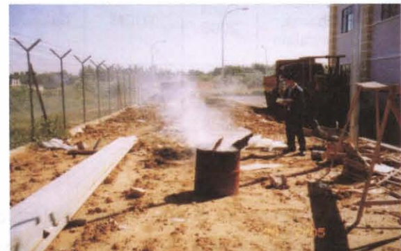
Gambar 4.26 : Sabah : Pembakaran Yang Dilakukan Di Tapak Bina.
