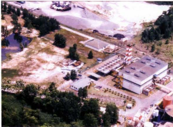
Gambar 3.3: Gambar menunjukkan contoh aktiviti projek yang mana tertakluk EIA; loji janakuasa stim menggunakan bahan api fosil melebihi 10 MW di daerah Sandakan.
