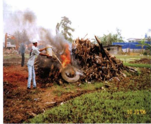
GAMBAR 4.15 kerja-kerja pepadaman oleh pekerja kontraktor binaan.
