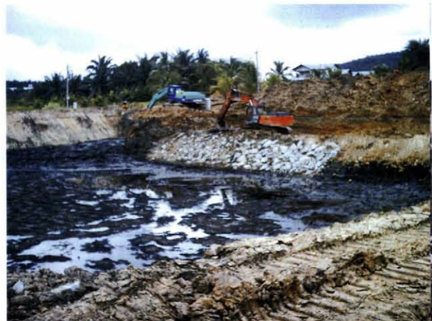
Rajah 3.7: Kolam pengolahan effluen sedang diperbaiki setelah kerja-kerja desludging selesai.
