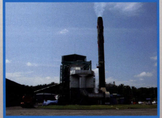
Gambar 3.2 : Pemeriksaan asap hitam daripada cerobong KKS secara visual asap
