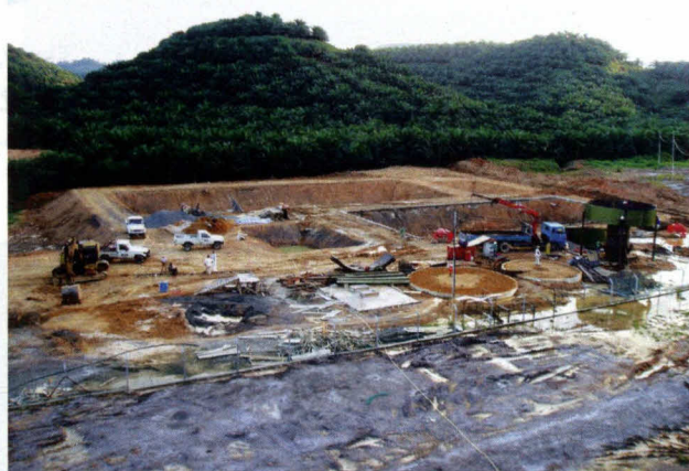
Gambar 3.6 : Pmbinaan Polishing Plant sedang dijalankan setelah KB diluluskan.
