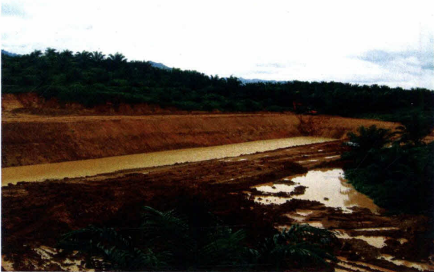
Gambar 3.8: Kerja-kerja pembinaan kolam pengolahaan effluen sedang dijalankan.
