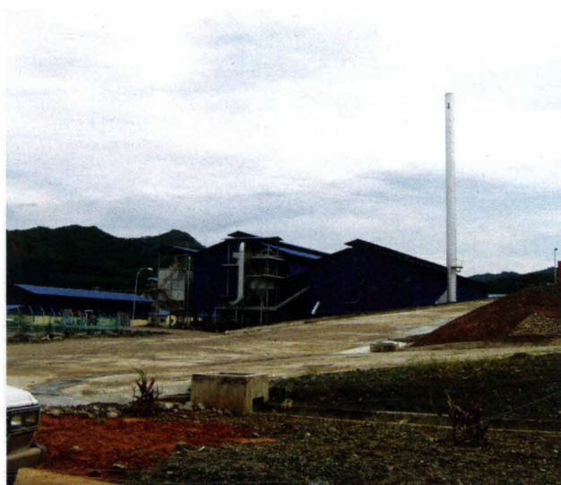
Gambar 3.11: Cerobong di Kilang Sawit.
