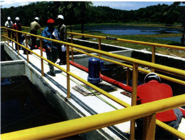
Gambar 3.9: Pemasangan polishing plant pada sistem rawatan effluen sedia ada.
