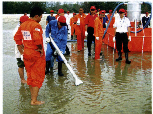
Gambar 4.8: Kaedah Penyedutan Minyak Di Pantai.
