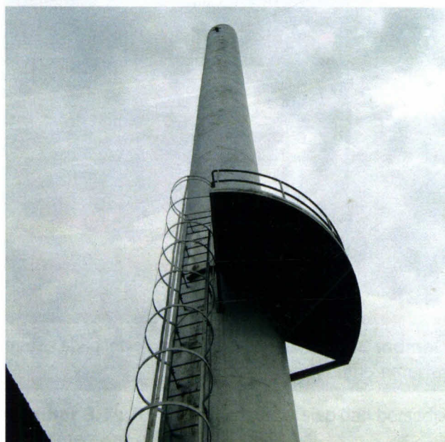
Gambar 3.12: 'Stack Platform' disediakan untuk kemudahan mengukur bendasing dari cerobong.
