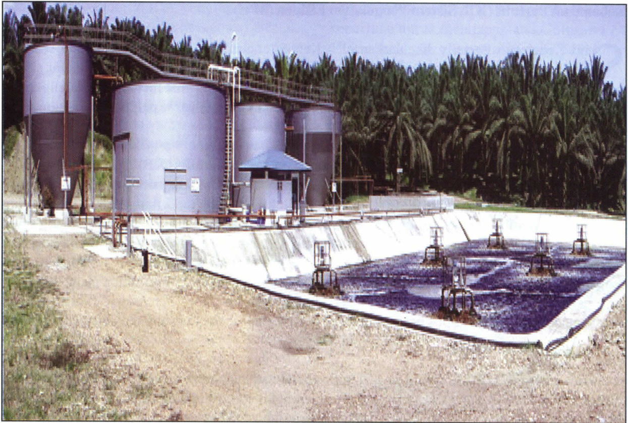
Gambar 3.8 : Polishing Plant yang sedang beroperasi
