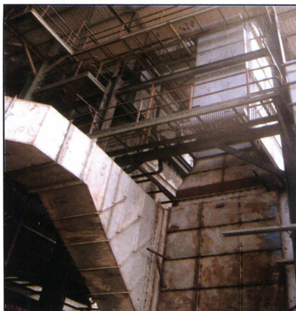
Gambar 3.12: Dandang dengan alat kawalan pencemaran ( multicyclone ) yang baru dipasang
