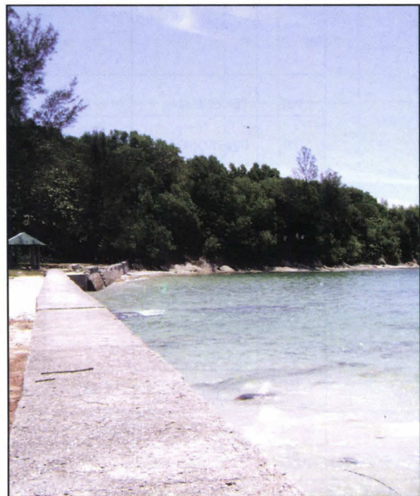
Gambar 2.1: Stesen Pengawasan Marin Di Pantai Bak-Bak, Kudat
