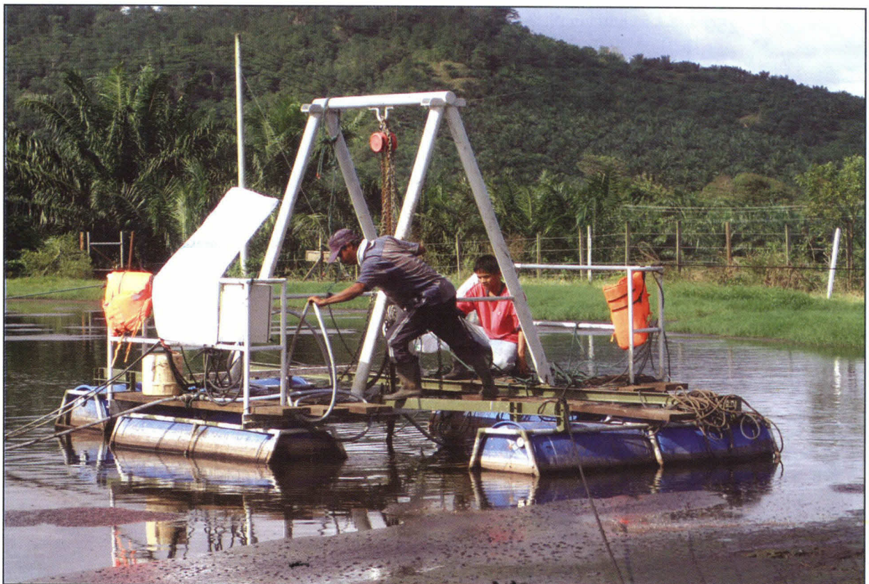
Gambar 3.9 : Kerja-kerja mencuci kolam pengolahan ( Desludging ) sedang dijalankan
