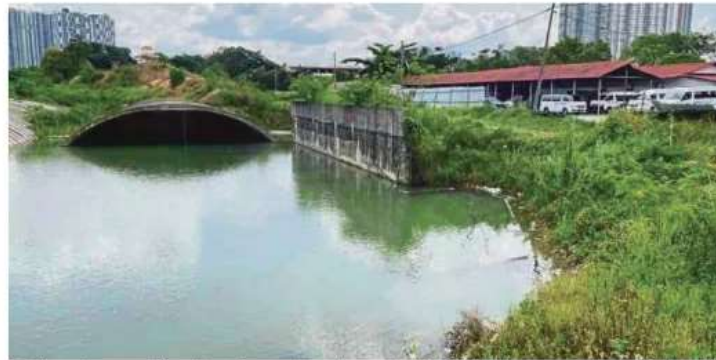
Projek penyimpanan air bawah tanah yang sedang dibangunkan JPS di PULAPOL.
