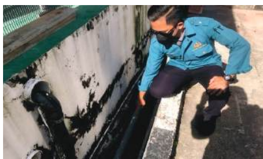
Pegawai sedang memeriksa Pelepasan Efluen Terolah Warna dan pH dari Sistem Pengolahan Efluen Perindustrian (SPEP).
