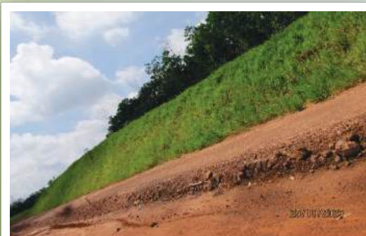
Cerun yang telah dibaiki dan dipasang Hydroseeding untuk mengelakkan hakisan tanah.
