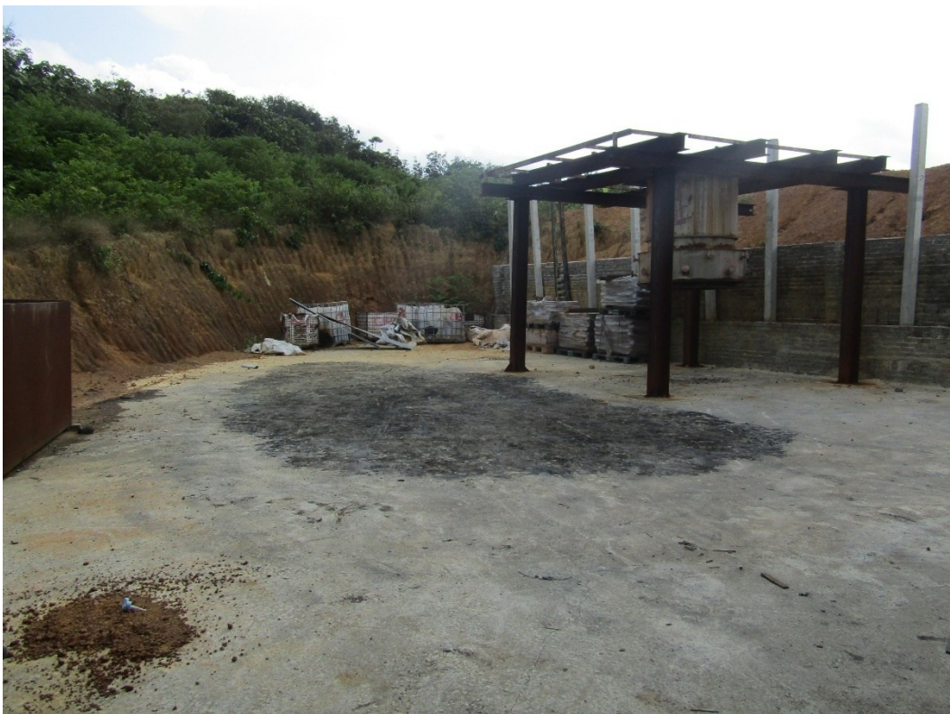
Dapur yang masih dalam fasa pembinaan di Kompleks C.
