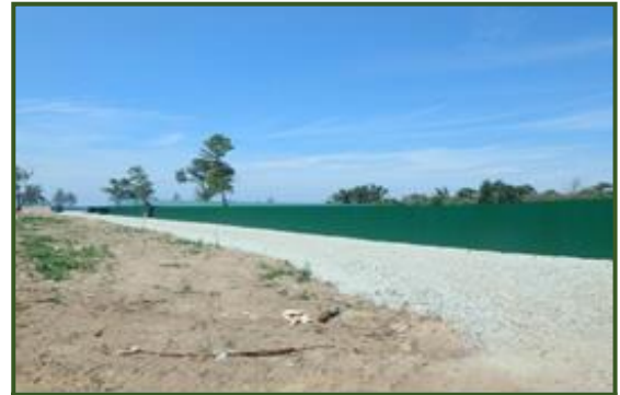
Pemasangan Penimbuhan Perimeter Zink
