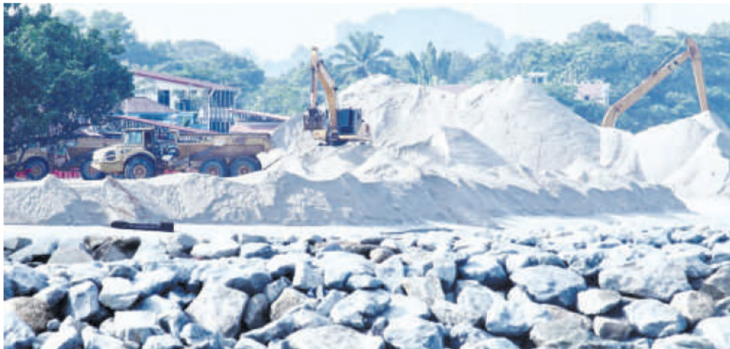
KERJA-KERJA menambak pasir dan membina benteng penahan ombak di Sungai Tuang, Pengkalan Balak bagi menangani masalah hakisan. Foto Muhammad Rasul Azli Samad
