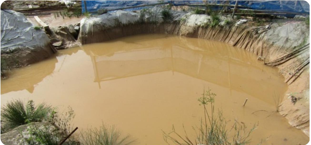
Gambarfoto 2.7: Binaan Perangkap Kelodak di Projek Pembangunan Bercampur
