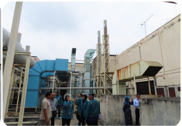
Gambarfoto 3.2: Pemeriksaan Pematuhan Premis kepada Peraturan-Peraturan Kualiti Alam Sekeliling (Udara Bersih) 2014
