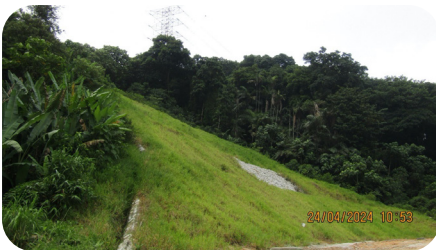
Gambarfoto 2.10: Turfing Cerun yang Terdapat di Projek UPNM
