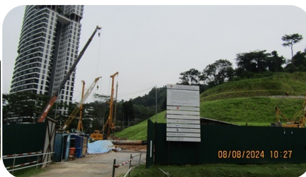
Gambarfoto 2.11: Pembangunan Cerun yang Terdapat dalam di Projek KL East
