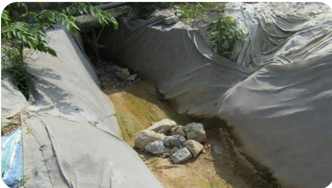
Gambarfoto 2.8: Binaan Check Dam di Projek Pembangunan Bercampur
