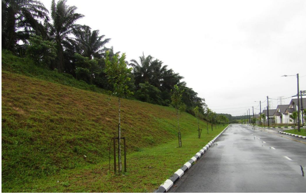
Rajah 2.12: Terracing dan penanaman rumput tutup bumi yang baik untuk menghalang hakisan
