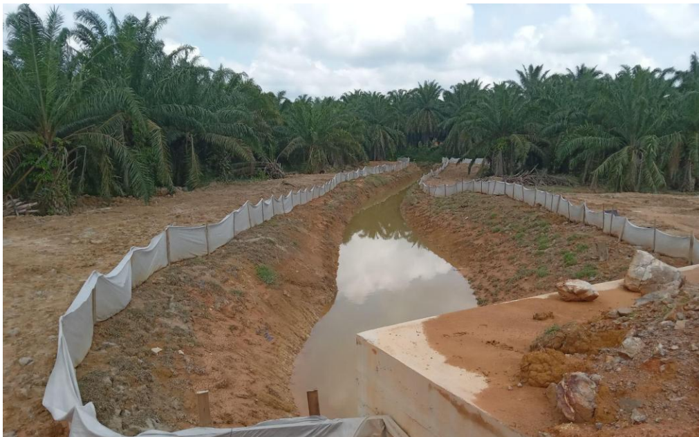
Rajah 2.13: Pemasangan silt fence sepanjang parameter projek bagi mengawal air larian permukaan
