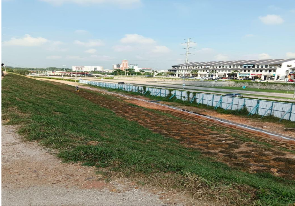
Rajah 2.10: Tebing yang telah dijalankan turfing dan concrete drain yang menghalang hakisan
