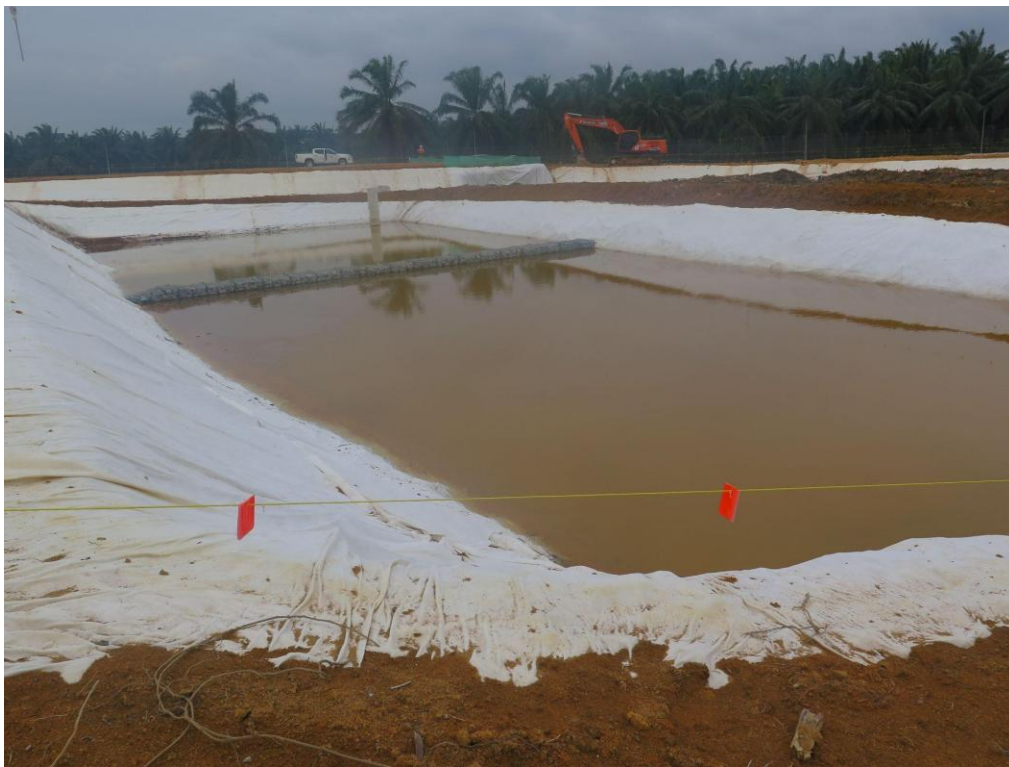
Rajah 2.11: Kolam perangkap mendap yang dalam dan berfungsi dengan baik
