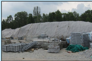
Contoh Timbunan Tanah Ditutup Dengan Geotekstil
