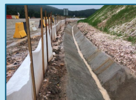
Pagar Kelodak di sepanjang Perimeter
