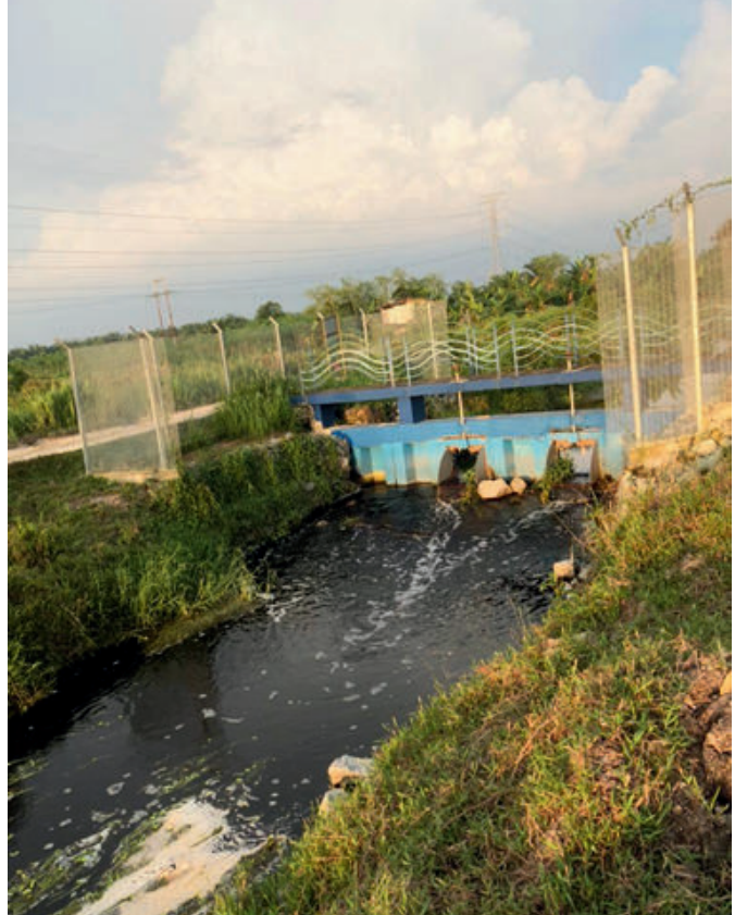
Foto 4.14: Check dam jenis geobag dan spin wheel yang dibina di kawasan fire prone di Negeri Selangor
