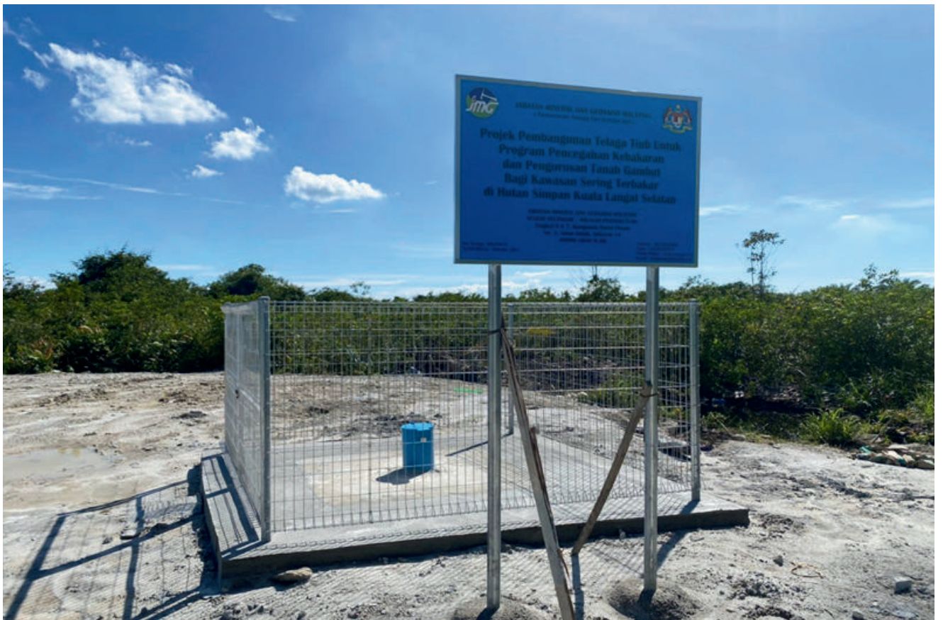
Foto 4.16: Tube well yang dibina di kawasan fire prone di Negeri Selangor
