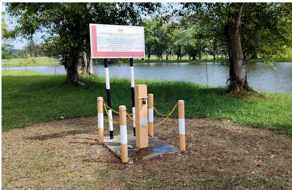
Gambar 10.2: Penyelenggaraan stesen air tanah di Sandakan
