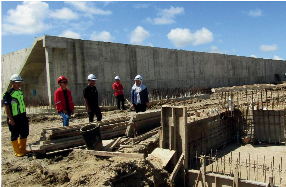
Gambar 2.3: Pasukan Penguatkuasaan EIA Menjalankan Pemeriksaan di kawasan projek semasa kerja-kerja tanah.
