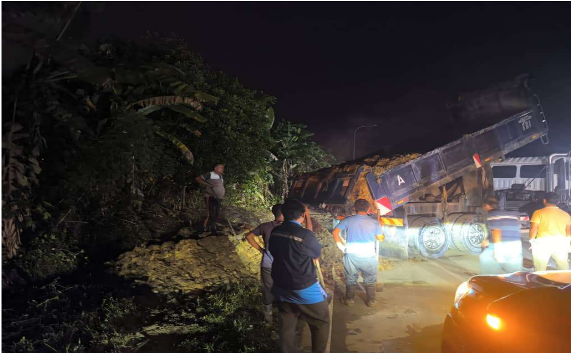
Gambar 7 & 8: Operasi pembersihan tumpahan Palm Oil Mill Effluent (POME). EFB ( empty fruit bunch ) turut digunakan untuk menyerap tumpahan
