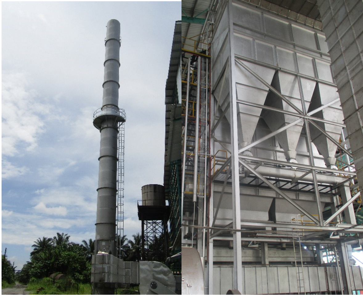
Rajah 40 Verifikasi di lapangan bagi pemasangan multicyclone dan cerobong.
