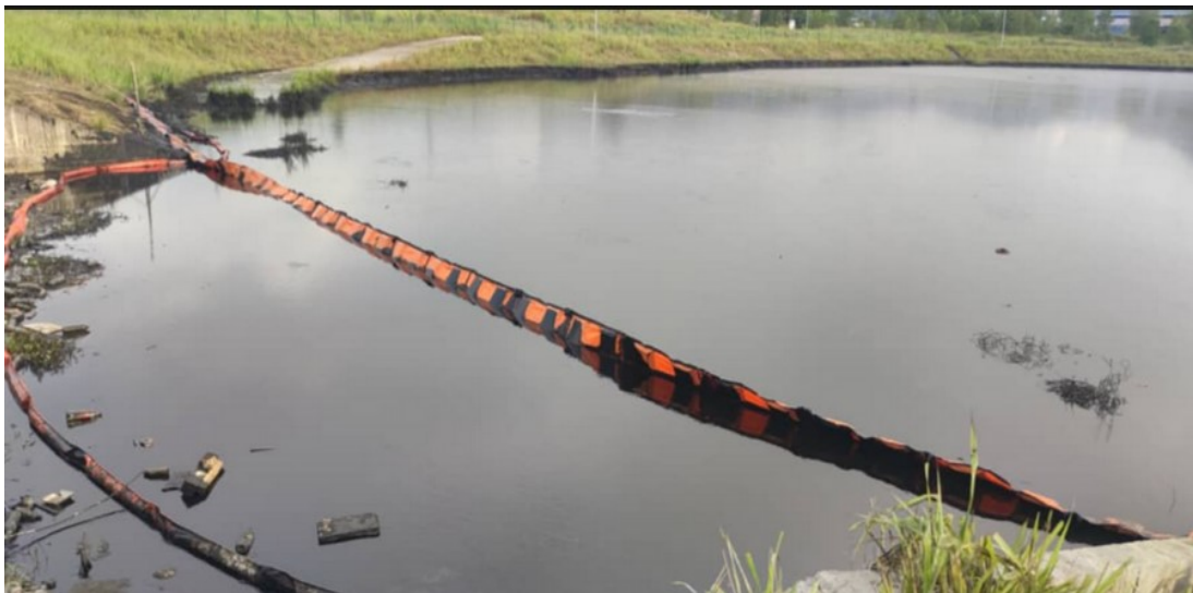
Gambar 26 : Pemasangan solid fence boom di kolam takungan banjir
