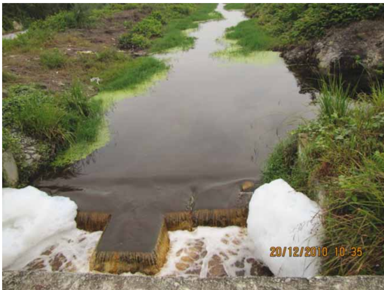
Pembinaan Sekatan Saliran di Johan Setia, Klang, Selangor Construction of Check Dam in Johan Setia, Klang, Selangor
