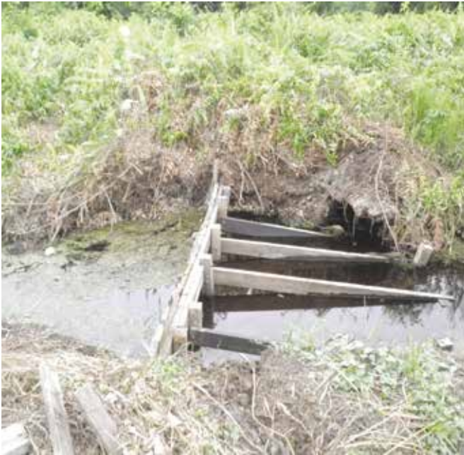
Pembinaan sekatan saluran di Miri, Sarawak Construction of check dam in Miri, Sarawak
