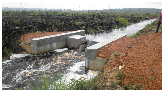
Sekatan saluran di Muar, Johor Check dam in Muar, Johor
