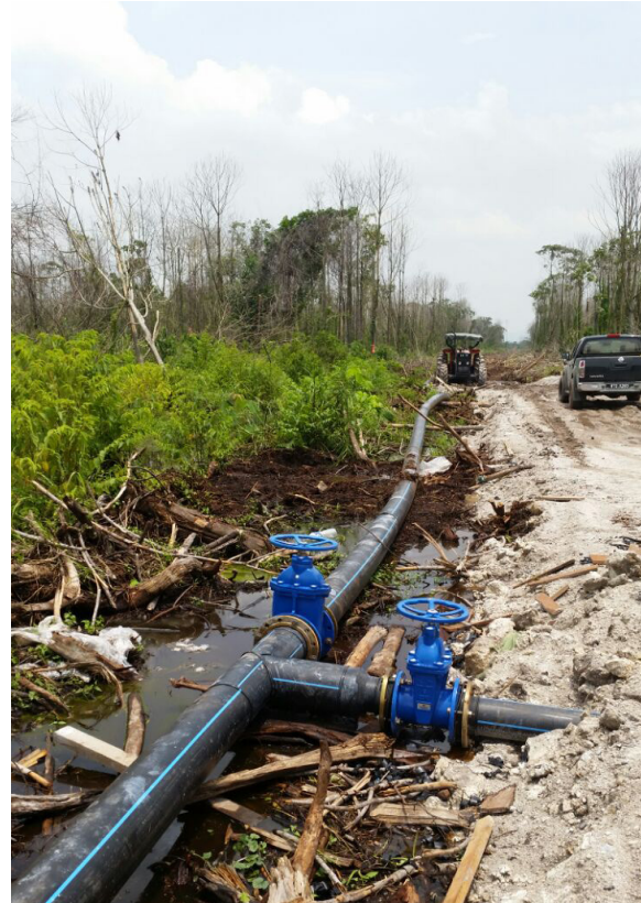
Paip Saluran Air di Hutan Simpan Raja Musa, Kuala Selangor, Selangor bagi meningkatkan paras air gambut Water Piping in Raja Musa Forest Reserve, Batang Berjuntai, Selangor to raise peat land water level
