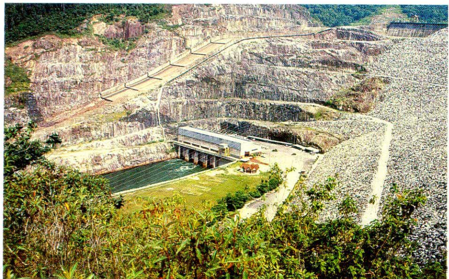
Empangan berfungsi sebagai tempat takungan air
