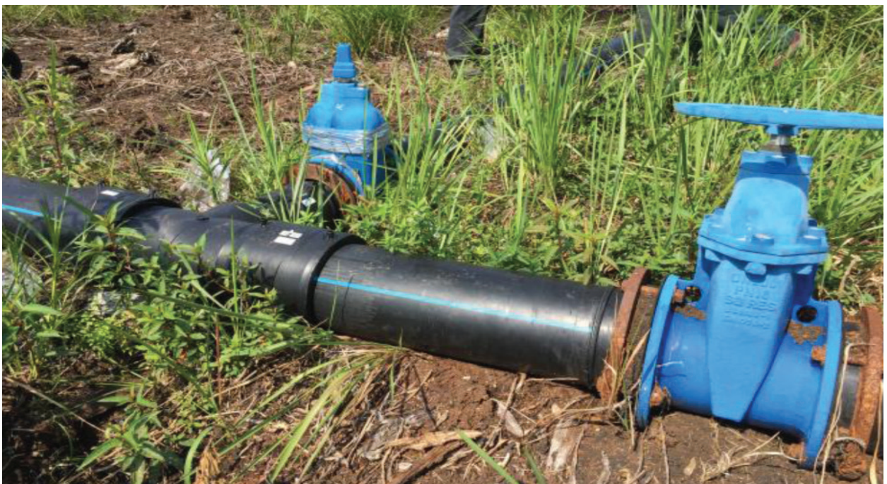
Paip Saluran Air di Hutan Simpan Raja Musa, Kuala Selangor, Selangor bagi meningkatkan paras air gambut Water Piping in Raja Musa Forest Reserve, Batang Berjuntai, Selangor to raise peat land water level
