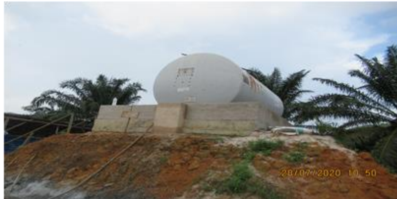
Gambar 3.3 : Skid Tank dibina dengan ban berkapasiti 110% isipadu untuk menampung tumpahan sekiranya berlaku.
