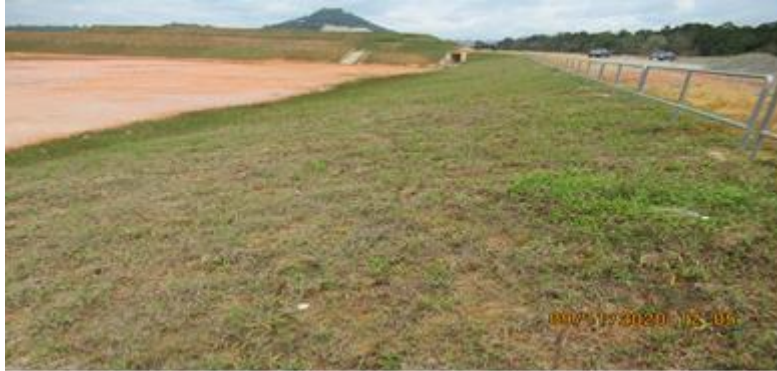
Gambar 3.2 : Penanaman rumput di tebing yang terdedah bagi mengelakkan hakisan tanah.
