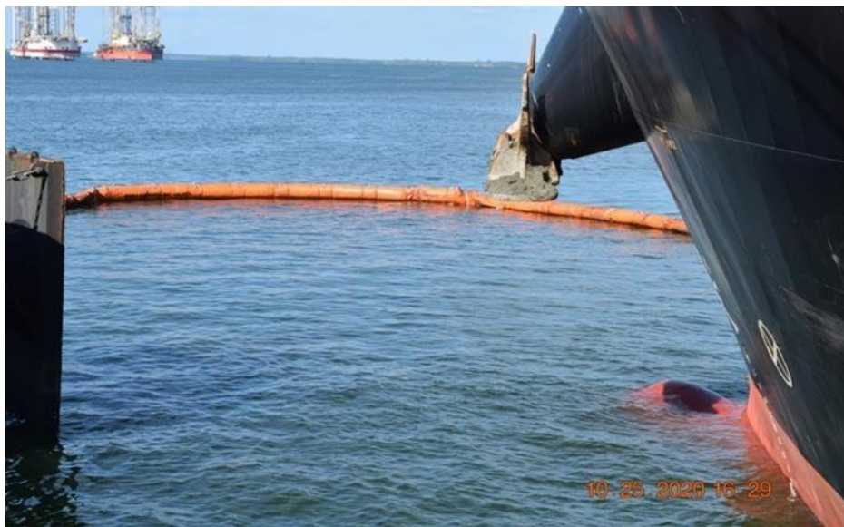
Gambar 4.12 : Pemasangan Oil Boom untuk mengelakkan tumpahan minyak yang berlaku terserak lebih jauh
