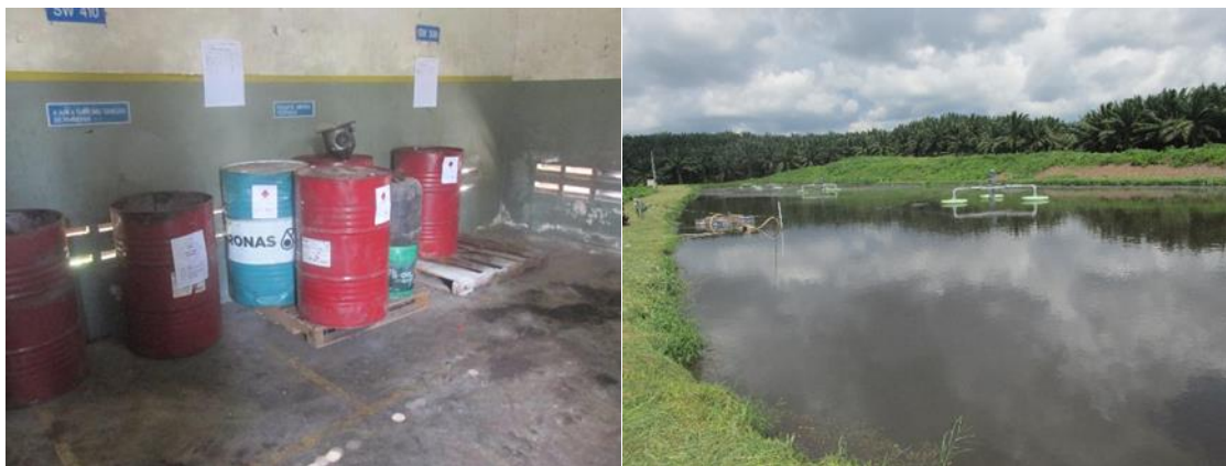
Gambar 9.5 : Stor Penstoran Buangan Terjadual dan kolam effluen yang terdapat di Kilang Kelapa Sawit di Kota Tinggi
