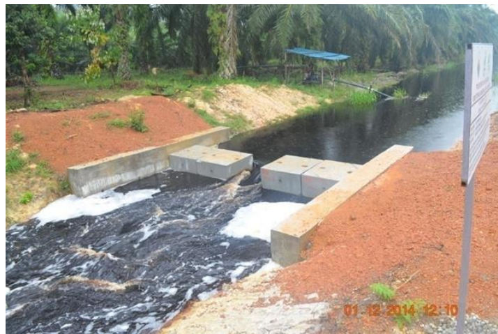
Gambar 4.8 : Check Dam Konkrit
