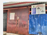
Penyimpanan Sisa Bahan Buangan Terjadual Yang Ditetapkan
