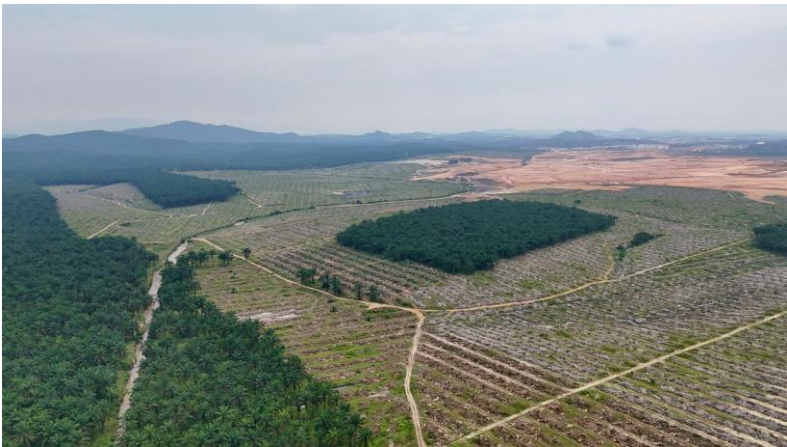
Keadaan semasa Plot C, MVV City Kawasan kerja tanah Peringkat 1 dimana Lokasi Cadangan STP terletak
