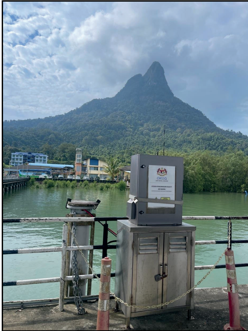
Foto 4.13 : Stesen pengawasan kualiti air marin automatik (CMWQM) yang terletak di kuala Sungai Santubong, Kuching
